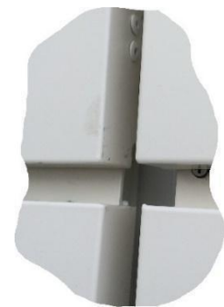
Alüminyum Levha Kaplama Kurgusu
