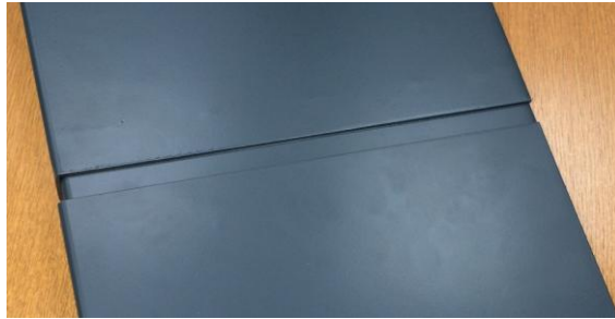
Alüminyum Levha Birimlerinin Geçme Yöntemi İle Birleşimi
