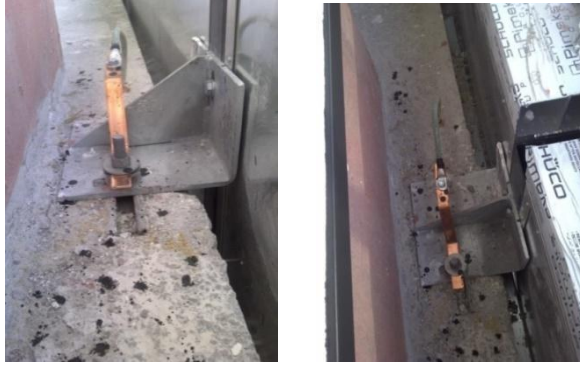
Cephe Topraklanması ile ilgili uygulama görüntüleri
