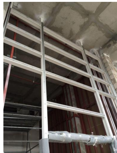
Çelik giydirmce cephe kurgusu / Çelik Bileşenlerin üretim evinde birleştirilmesi ve çerçeve olarak üretilmesi...
