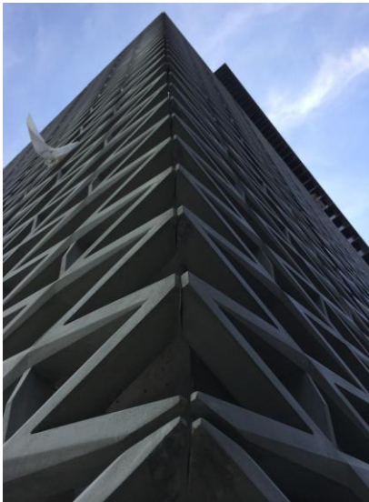
Ön Dökümlü Beton Kaplama Kurgusu
