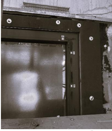
Çevre Yalıtım Hattında Yalıtım Örtüsü Üzerine Yapıştırılan Taşyünü Çivisi / Uygulama Örneği
