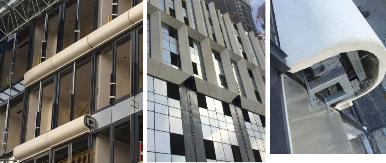
Giydirme Cephe Kurgusu Üzerine Bağlanan Sağır Kaplama Birimleri / Prekast Kaplama Uygulama Görüntüleri
