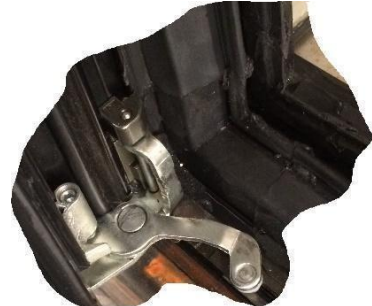
Köşe / Orta Bini Yalıtım Yastığı-Doğrama
